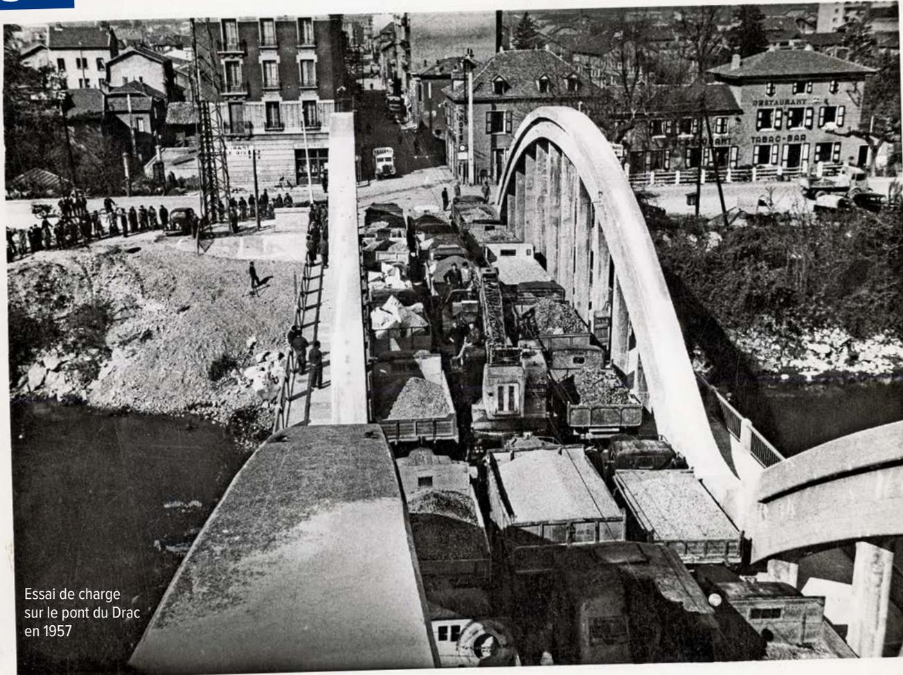
Essai de charge sur le pont du Drac en 1957
