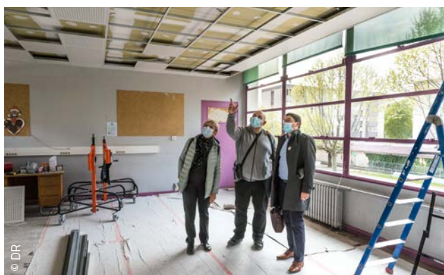
École Paul Langevin, reconstruction des faux plafonds.
